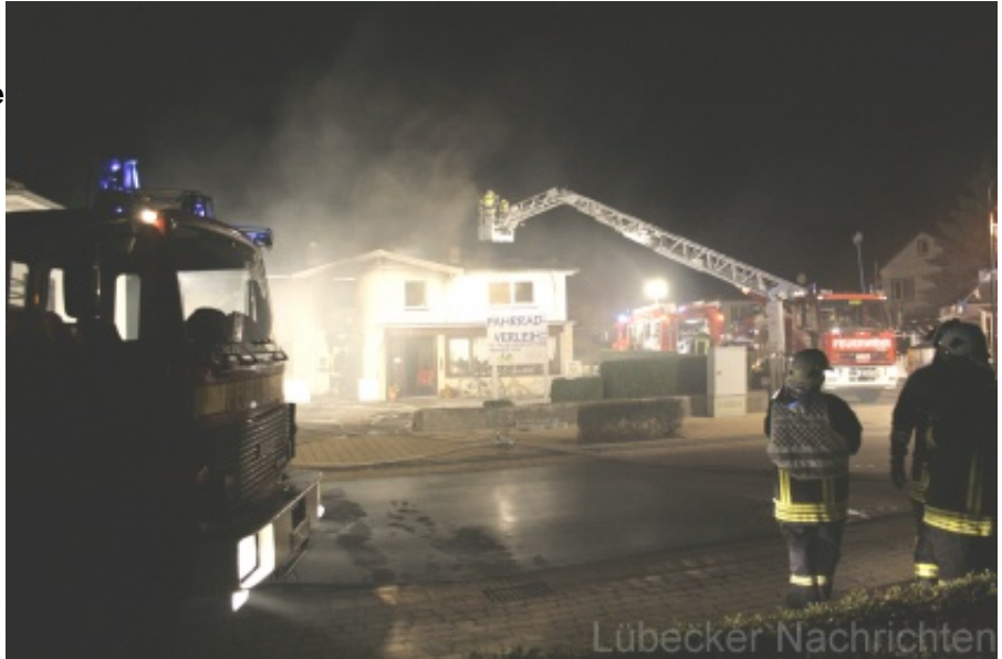
Dichter Qualm lag am Dienstagabend über der Haffkruger Strandallee: Eine Hälfte dieses Doppelhauses wurde durch ein Großfeuer völlig zerstört. Foto: Eckhard Meier
