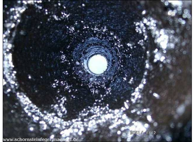
Glanzruß im Schornsteinrohr
